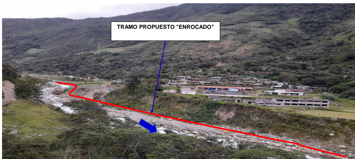
FIGURA N°02: TRAMO PROPUESTO PARA LA DEFENSA RIBEREÑA CON ENROCADO EN LA MARGEN IZQUIERDA DEL RIO SALKANTAY, ASI MISMO SE OBSERVA LA POBLACION VULNERABLE A EVENTOS EXTRAORDINARIO POR DESBORTE DEL RIO.
